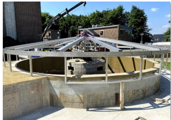
Under renovering og konstruktionsarbejdet
