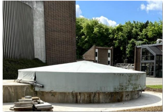
Før renovering og etablering af ny overdækning
