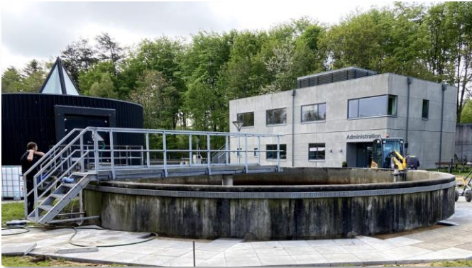
Før renovering og etablering af overdækning
