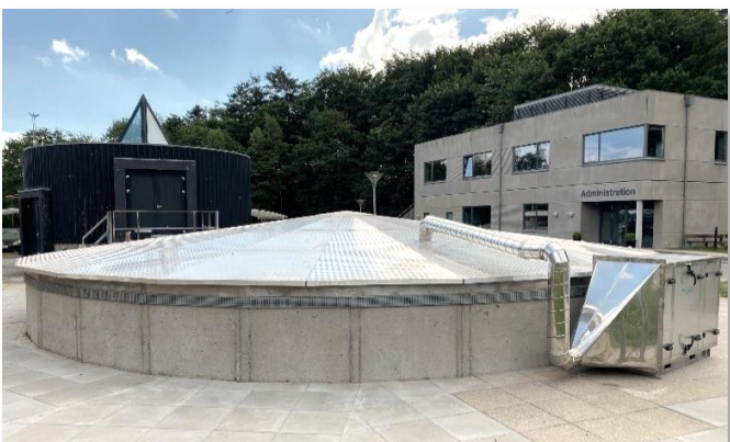
Efter renovering og etablering af overdækning
