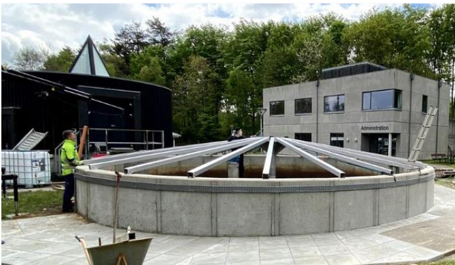
Under renovering og konstruktionsarbejdet
