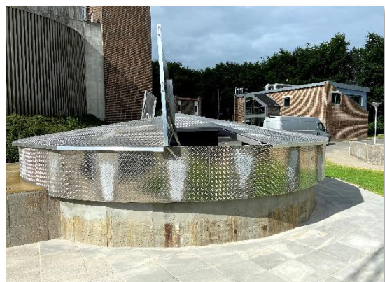
Efter renovering og etablering af ny overdækning
